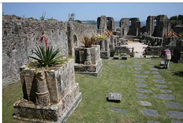
4. Ruines de l'Abbaye bénédictine Saint-Guénolé de Landévennec, XIe siècle, Cornouaille. Nef rythmée par des piles simples ouvrant de arcades donnant sur les bas-côtés.
