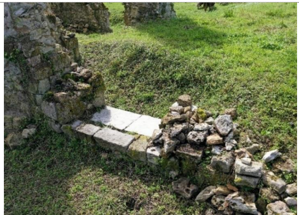
26. Seuil de la nef. Emmarchement maçonné localisé entre le bas-côté sud et la nef.
