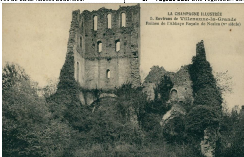
9. Vue Est de la façade Ouest. La végétation est dense et recouvre le transept et les chapelles Nord et Sud - Carte Postale – Non datée
