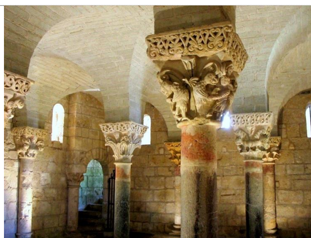
10. Crypte de l'église de Saint-Girons, XIe siècles, Landes. Dernier vestige de l'abbatiale. Couvrement en voûte d'arête.
