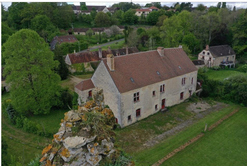
4. Vue aérienne de la maison abbatiale.
