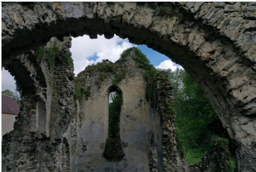
17. Vue générale du Transept Nord. Partie modifiée par un abbé donateur. Anciennement, la baie haute était dotée d'un vitrail.
