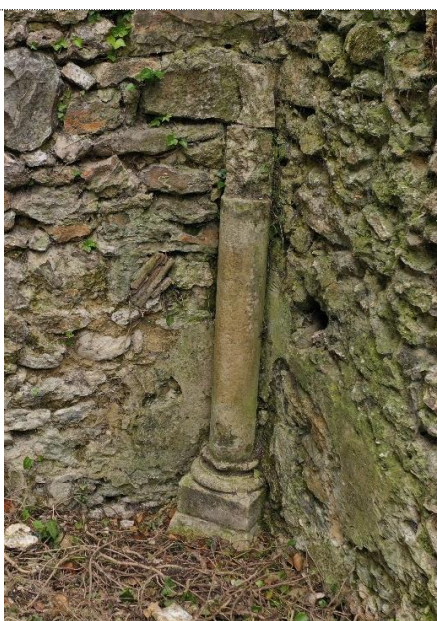
15. Vestiges de fût de colonne. Angle Nord Est de la chapelle Nord.
