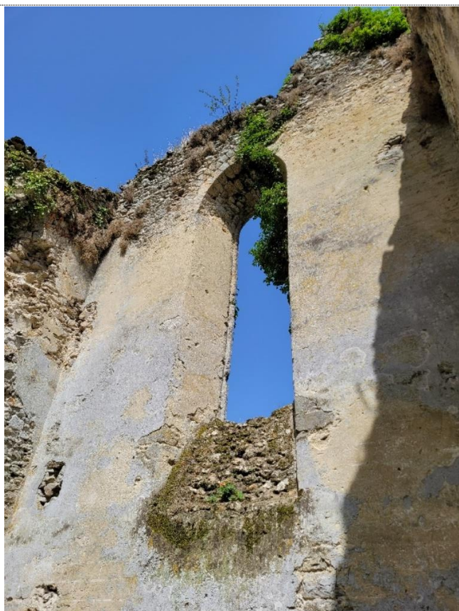
6. Bras Nord du transept. Bonne conservation des maçonneries en parties hautes, avec par endroit des vestiges des enduits primitifs.
