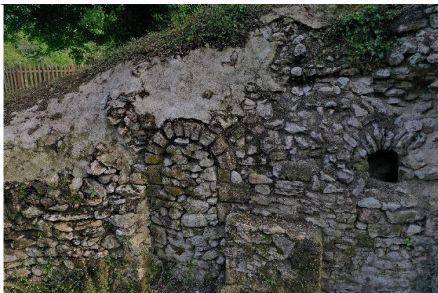
18. Absidioles latérales de la crypte. Arcs en plein cintre. Aujourd'hui bouchées ou remblayées par des pierres.
