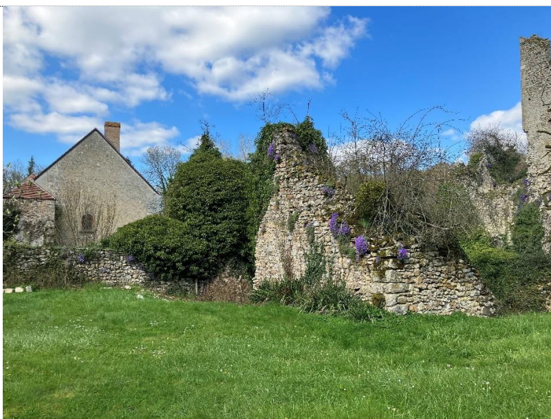
5. Vue générale du site. Pignon Sud de la maison abbatiale, Façade Ouest en moellons de l'abbaye.
