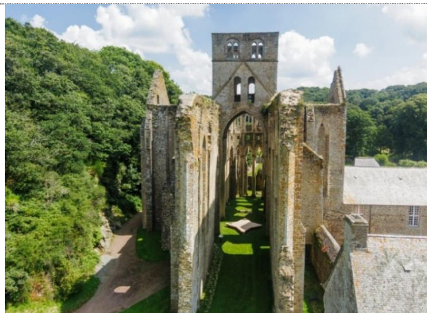
2. Ruines de l'Abbaye bénédictine Notre-Dame de Hambye, XIIe siècle, Normandie. Les baies du premier niveau sont intérieures et donnent sur la charpente de la nef.
