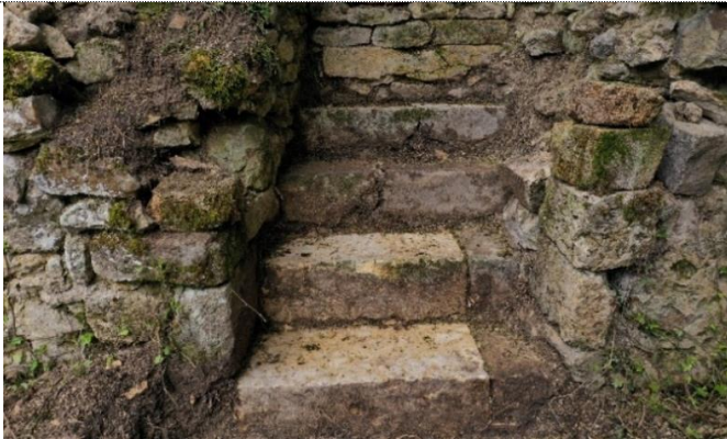
23. Chapelle Sud. Escalier d'accès au chœur.
