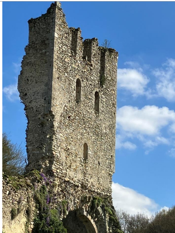
8. Vue Nord-Ouest. Les deux tiers de la façade Nord se sont effondrés.
