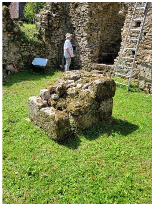
23. Base de pilier, 1 ère travée de la nef. Probablement la pile la plus authentique et la mieux conservée de l'ensemble.
