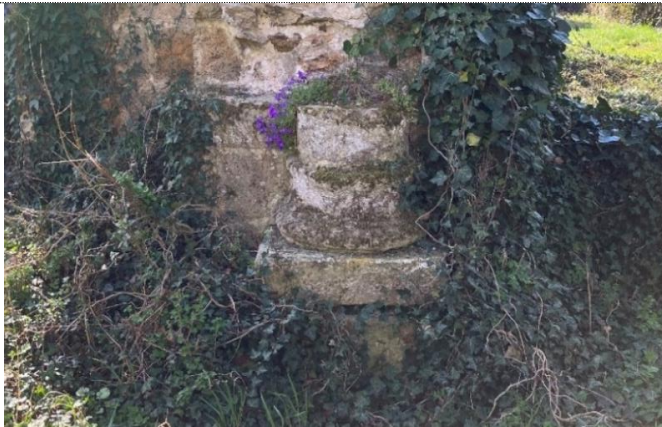
21. Transept Sud. Fûts et bases de piliers.
