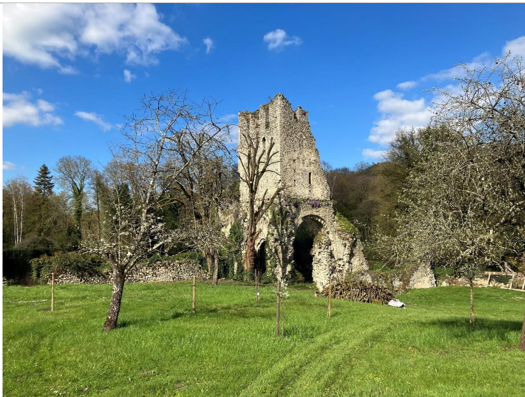
9. Vue Sud-Ouest. La moitié du clocher sud s'est effondrée. La baie haute est bouchée.
