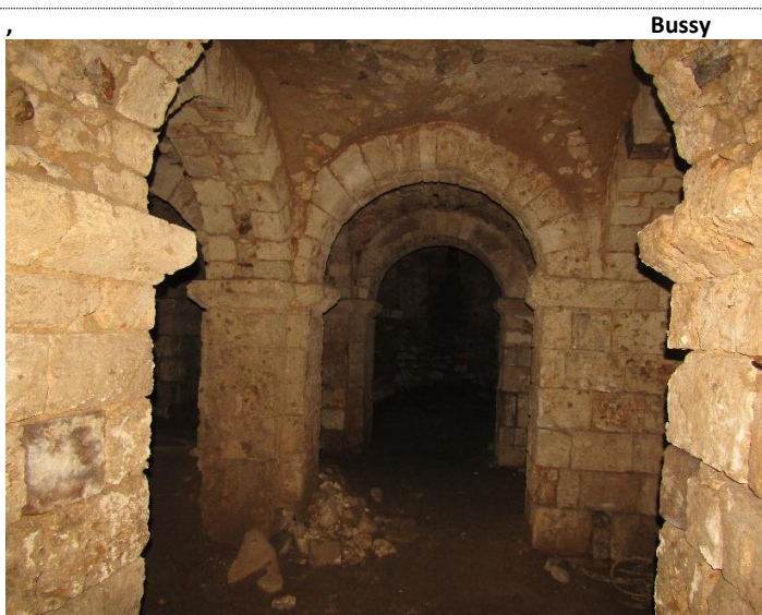
11. Crypte du château de Broyes, XIe siècle, Bussy-le-Château, Marne. Couverture en voûte d'arête et piles primitives.
