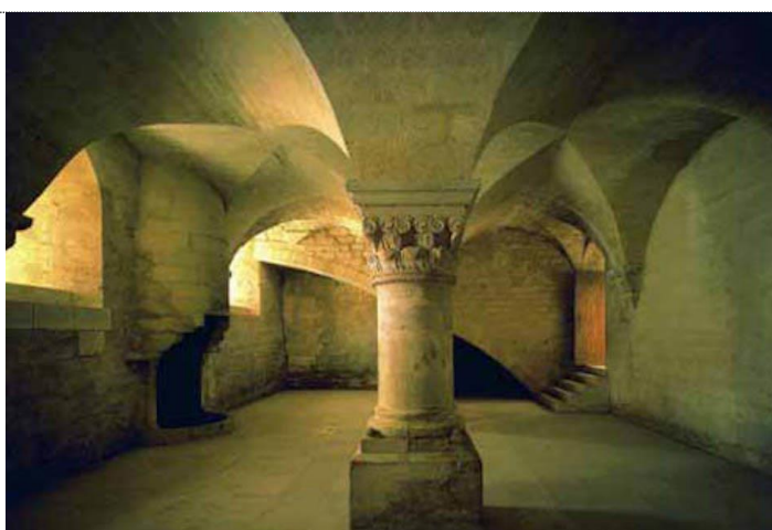
9. Chauffoir de l'abbaye cistercienne Notre-Dame de Sénanque, XIIe siècle, Vaucluse. Couverture en voûte d'arête.
