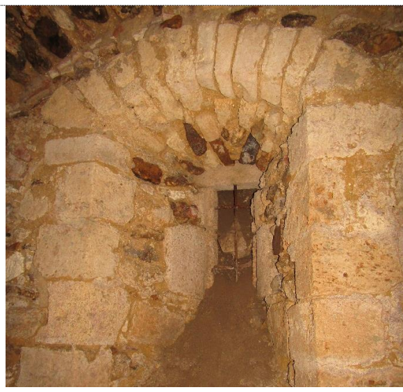
12. Crypte du château de Broyes, XIe siècle, Bussy-le-Château, Marne. Baie basse éclairant la crypte.
