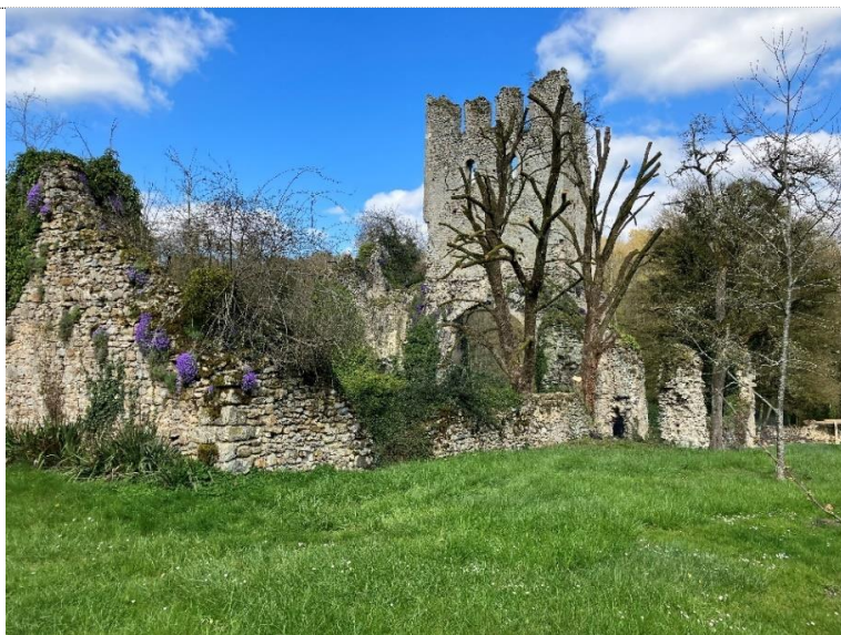
6. Vue générale des ruines de l'abbaye de Nesle-la-Reposte. Murs en moellons du bas-côté Sud et de la nef, Tour du clocher à trois niveaux.
