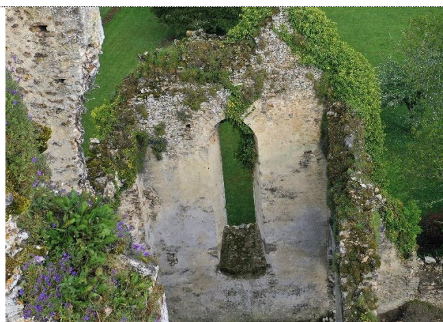
19. Transept Nord. Baie ogivale haute, postérieure à la construction initiale du XI ème siècle.
