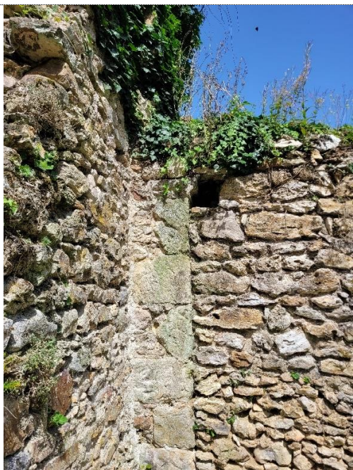
22. Mur refermant la nef au Nord. Vestige d'un tailloir qui indique le départ des arcs du bas-côté au Nord.
