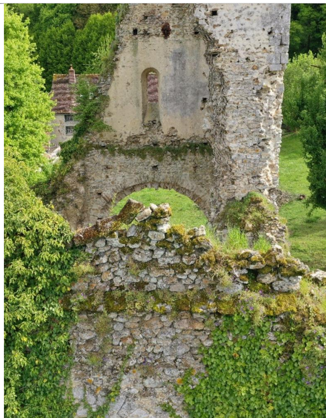
7. Bras Nord du transept. Bonne conservation des maçonneries en parties hautes, avec par endroit des vestiges des enduits primitifs.
