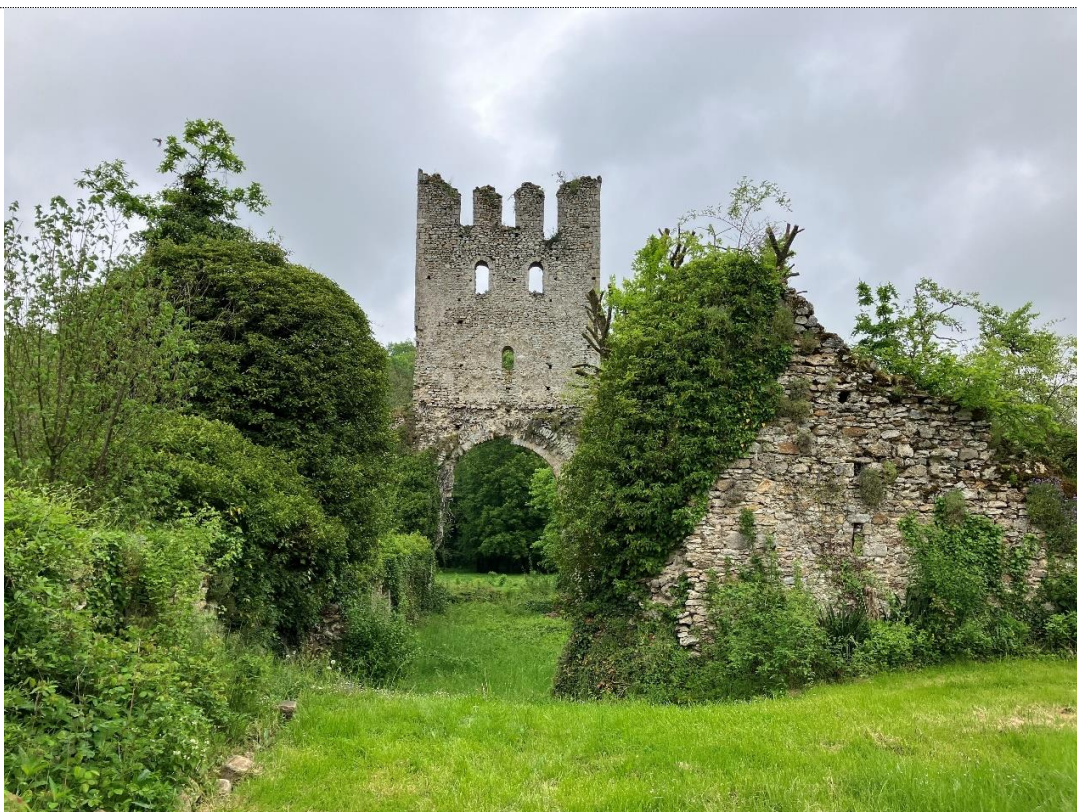
10. Façade Ouest. Tour du clocher. Au centre, l'emplacement de l'ancien portail royal déplacé à Villenaux.
