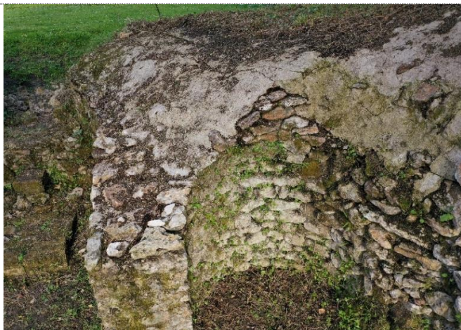
20. Absidioles de la crypte. Chape en béton mise en place sur ces soubassements. Perte progressive de cette chape à cause des intempéries et l'érosion des niveaux de sol
