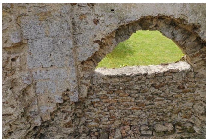
18. Transept Nord. Arc ogival bouché lors de la destruction du bas-côté au Nord.
