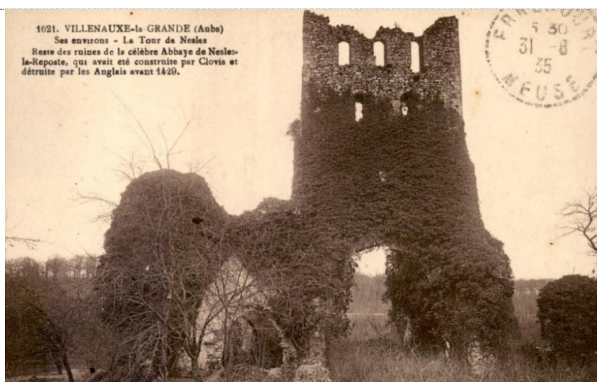
10. Façade Ouest. A droite, l'arc ogival du bas-côté Nord est ouvert et on peut lire la hauteur du faîtage. Carte Postale – Non datée
