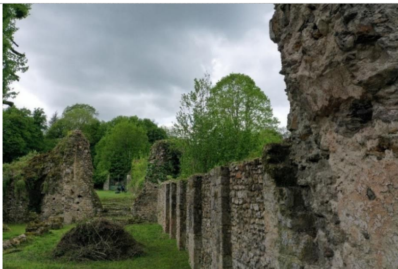
12. Vue générale de la nef. Mur spélatif construit à la destruction du bas-côté Nord. On distingue les piles des arcs de la nef.
